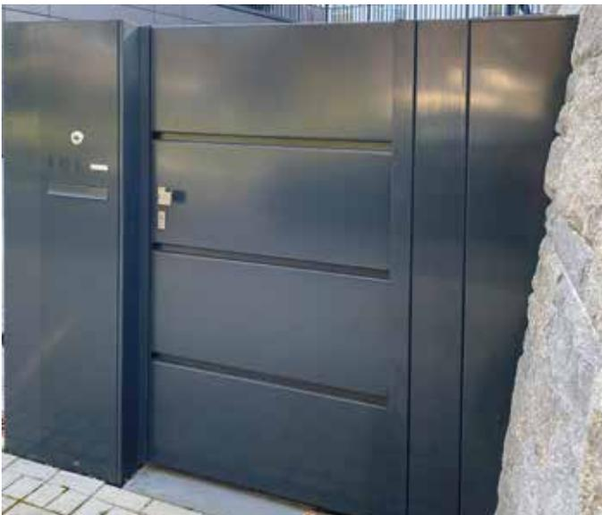
Tor mit Kassettenblechfüllung und waagerechter Sicke
