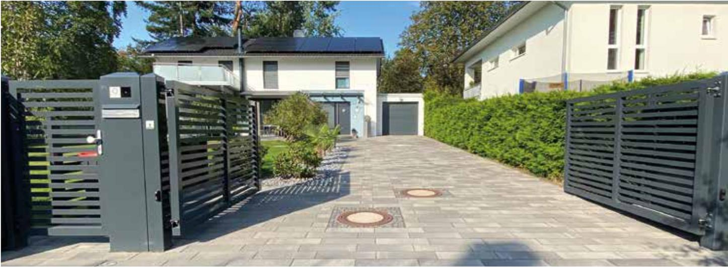
Tor mit waagerechter Stabfüllung und Nebeneingangstür
