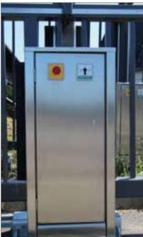
Antrieb Totmann bestehend aus Antriebsmotor GSA 2000, Edelstahlsäule 440 x 300 x 950 mm mit Fronttür, PZ vorgerichtet, Oberfläche: gebürstet K 200, Zahnriemen 25/32 ATL 10 verdeckt im Laufwerk montiert, 2 Schlüsselschalter, 1 Not-Aus-Schalter, 1 Halt-Taster, Wendeschützsteuerung in Gehäuse, berührungslose Magnetendschalter.
