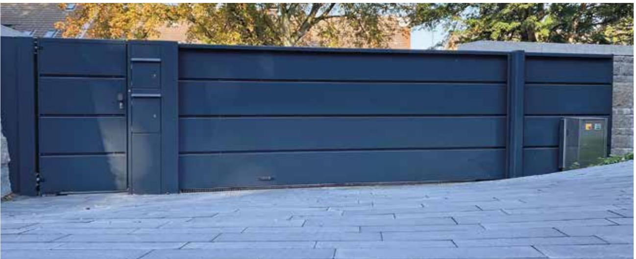
Schiebetor mit Kassettenblechfüllung und waagerechter beidseitiger Sicke
