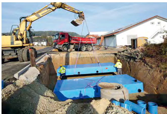
Flache Elemente und damit ein flacher Einbau bedeuten weniger Erdaushub; das leichte Gewicht sorgt für einfache Handhabung an der Einbaustelle.
