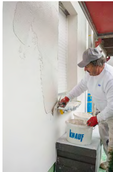
Der mineralische Knauf MineralAktiv Scheibenputz wird direkt aus dem Eimer auf die Wand aufgebracht. (Foto: Knauf)
