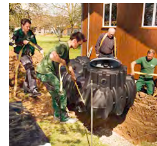
Der Tank wird vorsichtig platziert.
