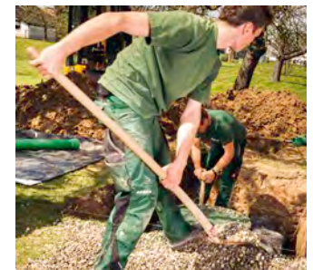
Mit Rundkornkies wird aufgefüllt.
