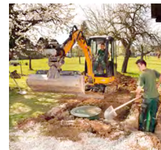
Das Gelände wird verdichtet.
