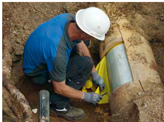
Nach dem Freilegen des Inliners sind Trennfolien unbedingt zu entfernen.
