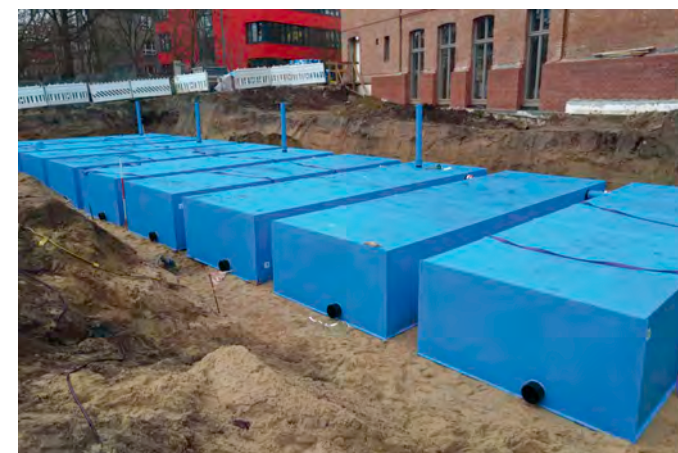
Mehrere KS-Bluebox-Elemente können vor Ort an der Einbaustelle miteinander verbunden werden.
