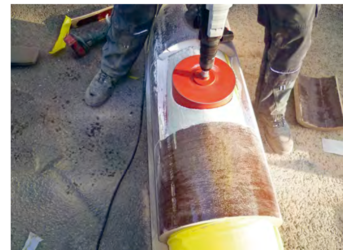
Herstellung der für die Montage des Liner-Anchlusses System CONNEX benötigten Bohrung.
