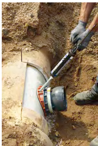
Der Einbau des Liner-Anchlusses System CONNEX. Über eine Öffnung im Distanzring wird die Dichtmasse eingeführt.
