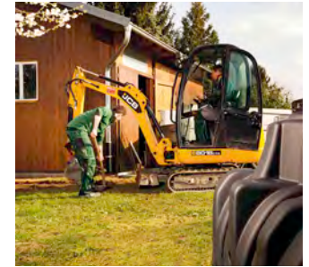
Die Baugrube wird ausgehoben.
